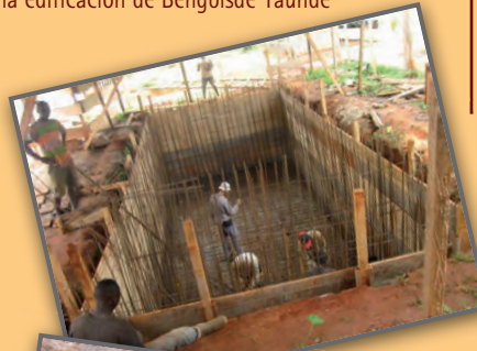
Plaza Excavación para introducir los cimientos de una edificación de Bengbisde Yaundé
